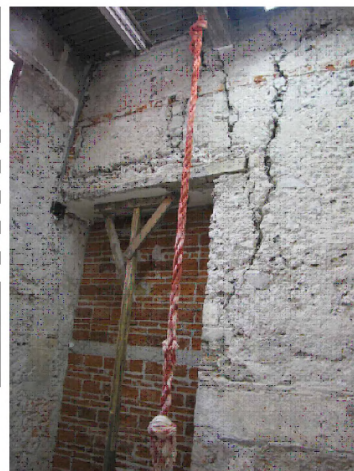
Figura 1 Estado actual de vano existente
