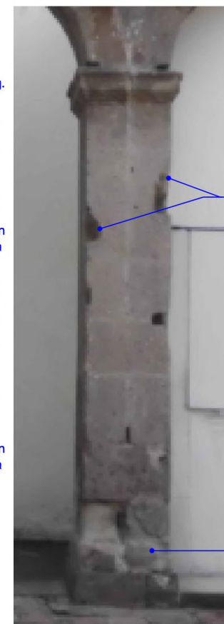
Exfoliación de cantera en el plinto y pérdida de sección en el fuste
